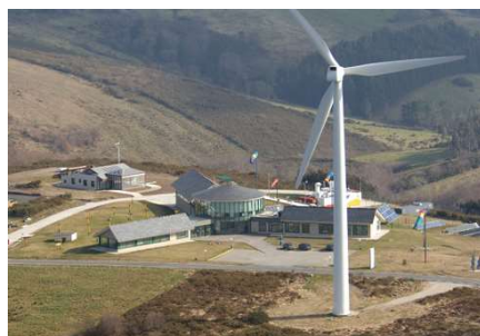
Instalación Solar Fotovoltaica SOTAVENTO
